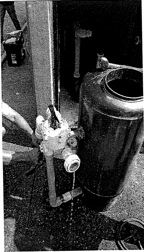
Mantenimiento de la valvula selectora (cambio de empaque)
